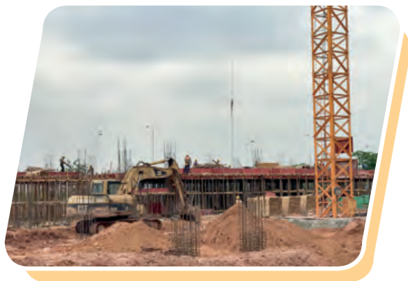
绿港·金阳产业城一期项目施工现场
