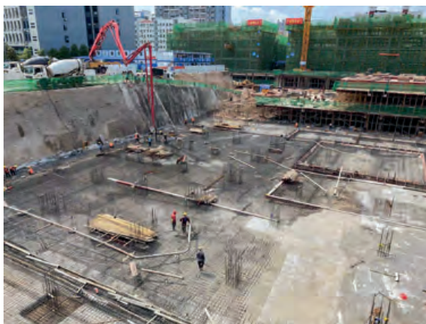
绿港·双创城项目1#楼筏板基础浇筑施工现场
